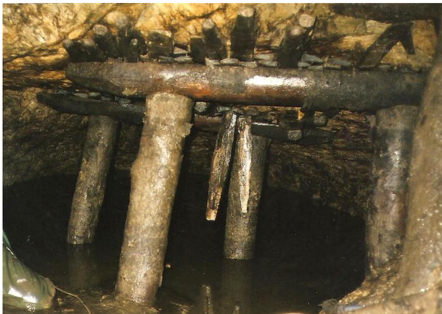
Fig. 73 - Les étais et planchettes de calage dans la mine des Massotais.
